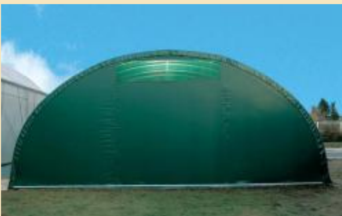
Geschlossener Giebel mit Lüftungsfenster aus PVC Folie 550g/m 2 (Typ LKW Plane)
