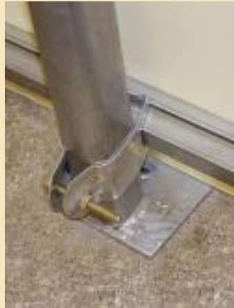
Option: Befestigung mit Klemmprofilen
